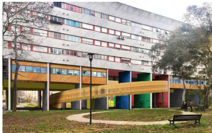
Intervento Trancia H - ante e post-operam.
