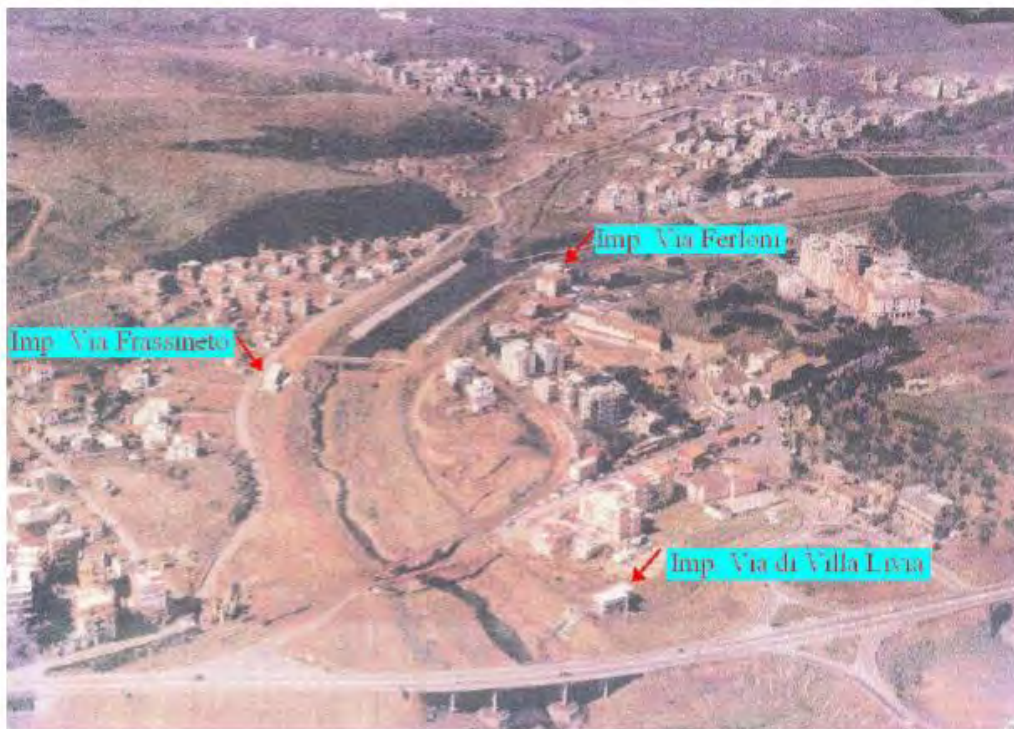
Fig. 2: Costruzione delle arginature, da Roma tre, op.cit.
