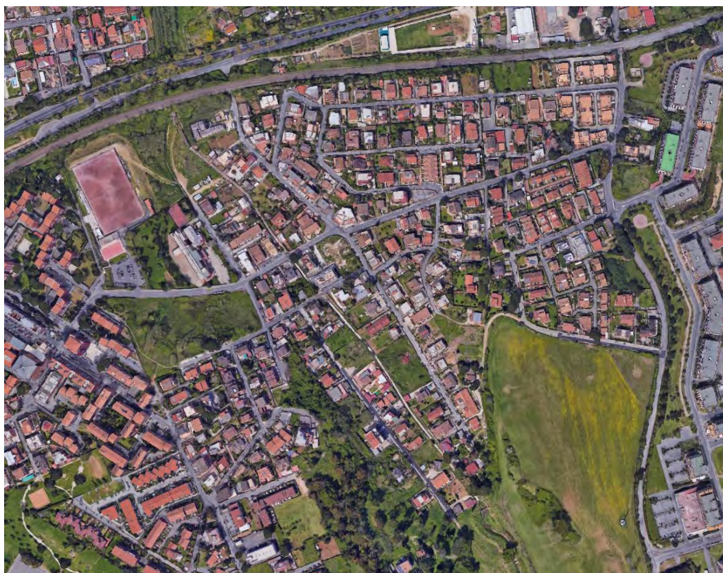
Fig. 1: Vista aerea del Fosso di Fontanile nel tratto urbanizzato
