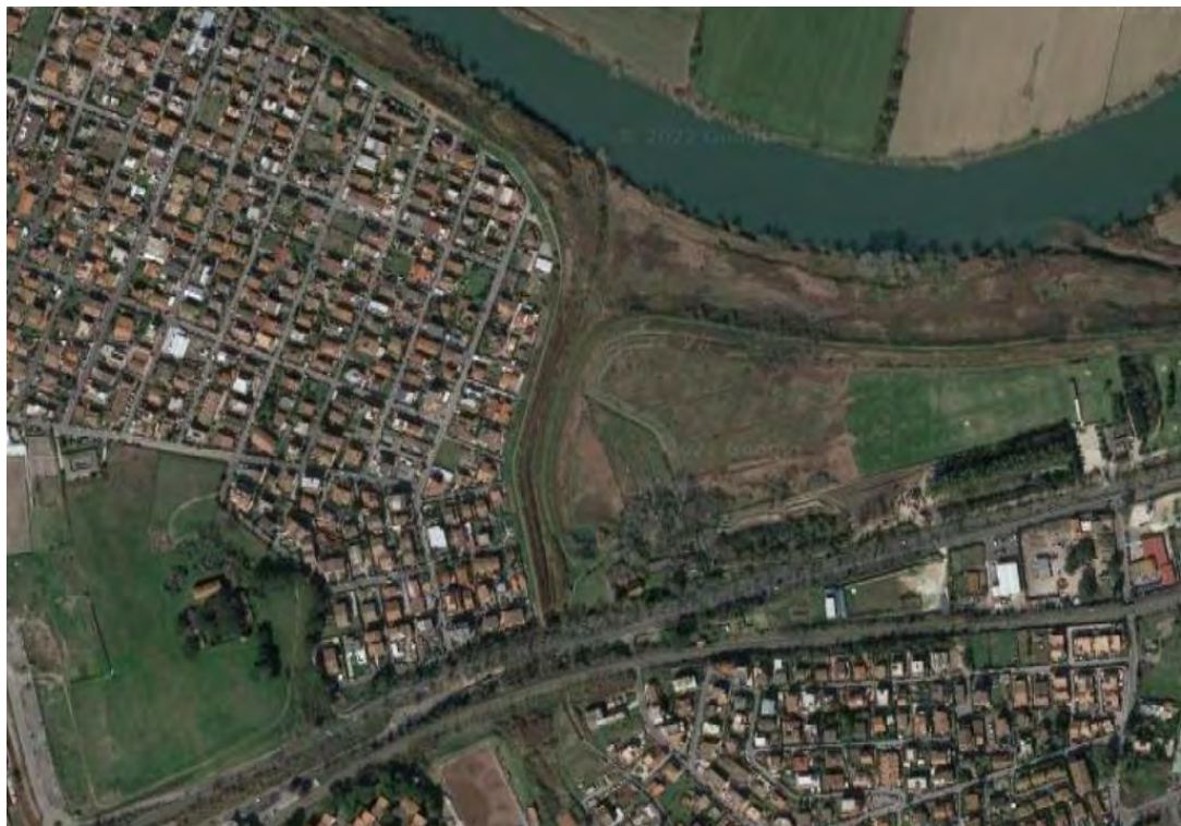
Fig. 3: Vista aerea del Fosso di Fontanile nel tratto a valle della ferrovia
