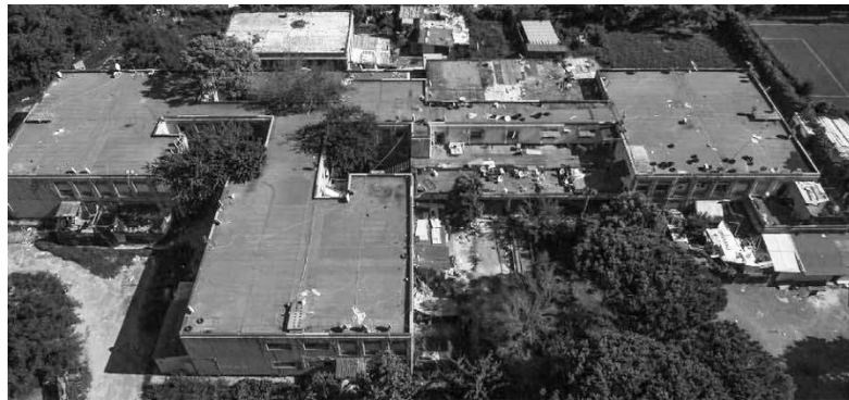
① Vista aerea facciata Ovest
