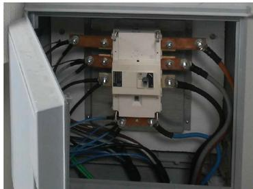
ALLOGGIAMENTO PER FORNITURA TRIFASE 230/400 V CON POTENZA CONTRATTUALE SUPERIORE A 80 kW - CONTATORE ELETTRONICO TRIFASE 2G AD INSERIZIONE SEMI-DIRETTA TIPO GESIS INCLUSO COMPLESSO TA COMPATTO 125/5 (K=25)
