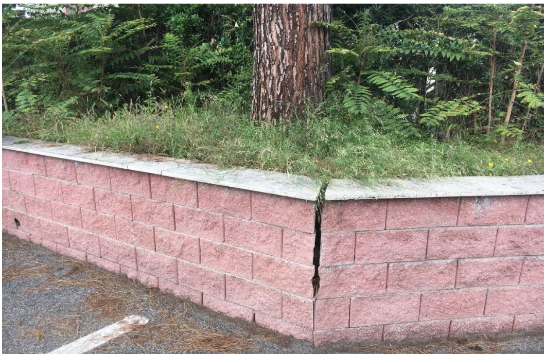
Aiuola di contenimento collassata per la spinta della zolla
