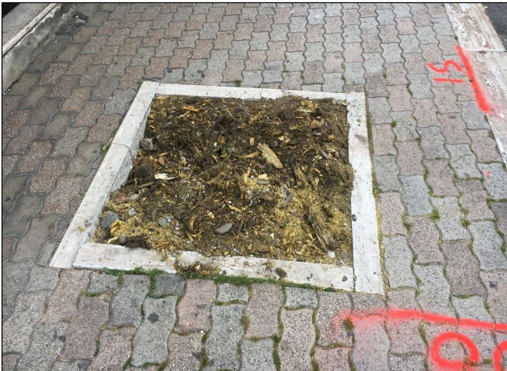
Aiuola alloggiamento di un albero abbattuto su marciapiede. Oltre ad essere un sito non idoneo ad ospitare alberi per le ridotte dimensioni (meno di 1 m 2 ), opera anche una chiusura del marciapiede poco fruibile dai pedoni e non fruibile da disabili.
