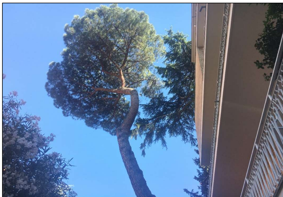
Pino domestico interferisce con i balconi di edificio residenziale
