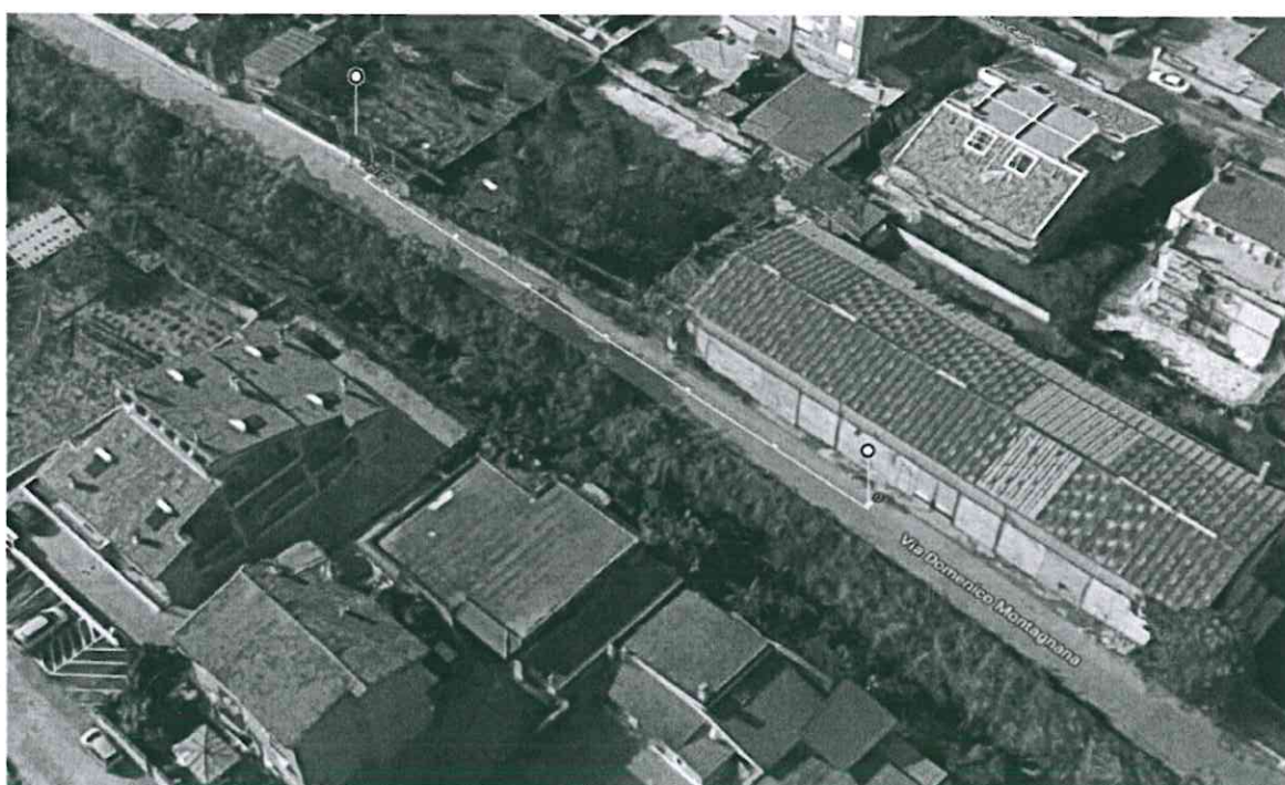
Figura 6 – Rilievo di massima della zona interessata dal dissesto – 2° tratto
