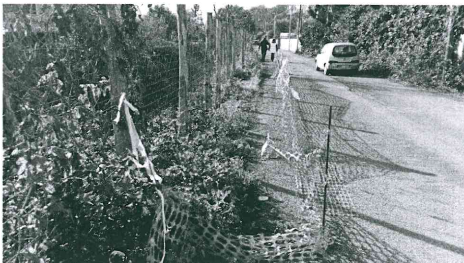
Foto 2 - 2° tratto di Via Domenico Montagnana in dissesto
