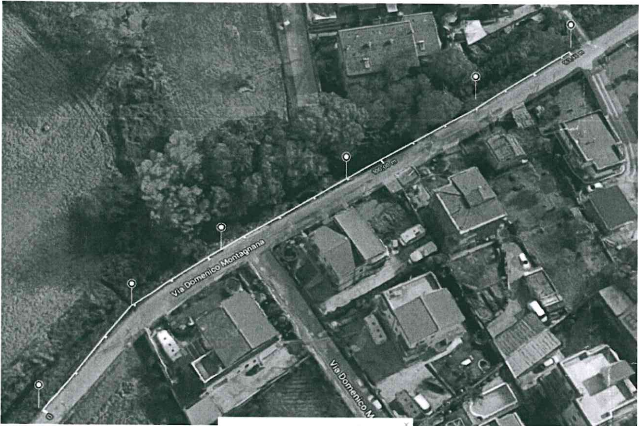
Figura 5 – Rilievo di massima della zona interessata dal dissesto – 1° tratto
