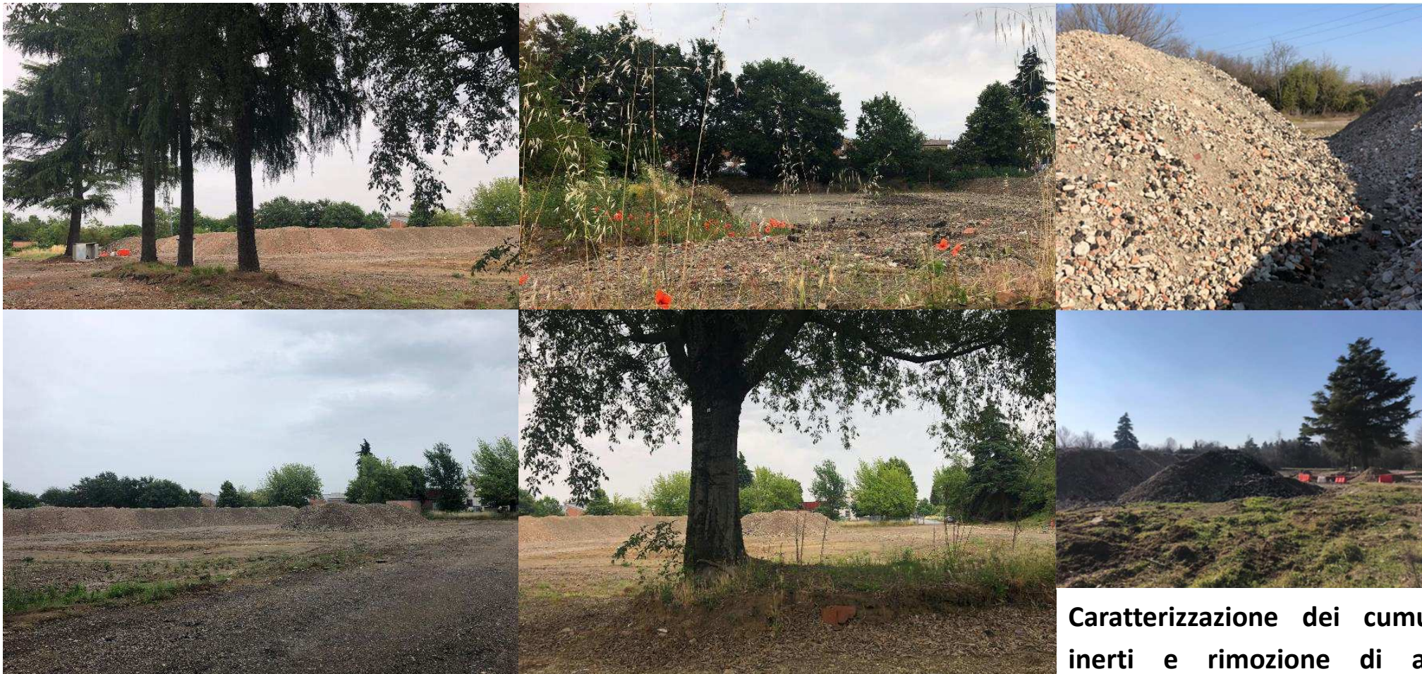
Livellamento terreno e selezione inerti che possono essere riutilizzati in loco
